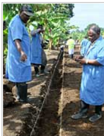
実習で施工状況の確認をするATTIインストラクター（右）と研修員（左）
